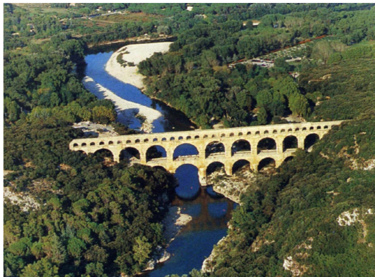
Pont du Gard, source photo : www.leclosdesromains.com
