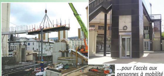
Bellevue, mise en place de la passerelle urbaine...
