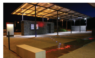
Accueil de la halte ferroviaire du Clapier
