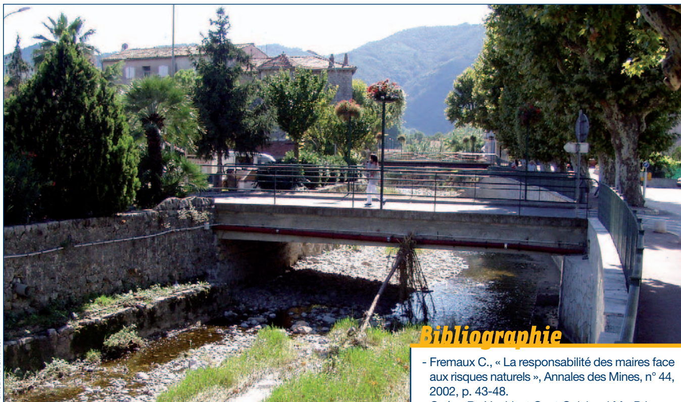
Pont sur la Mourachonne dans la commune de Pégomas, Alpes-Maritimes.
